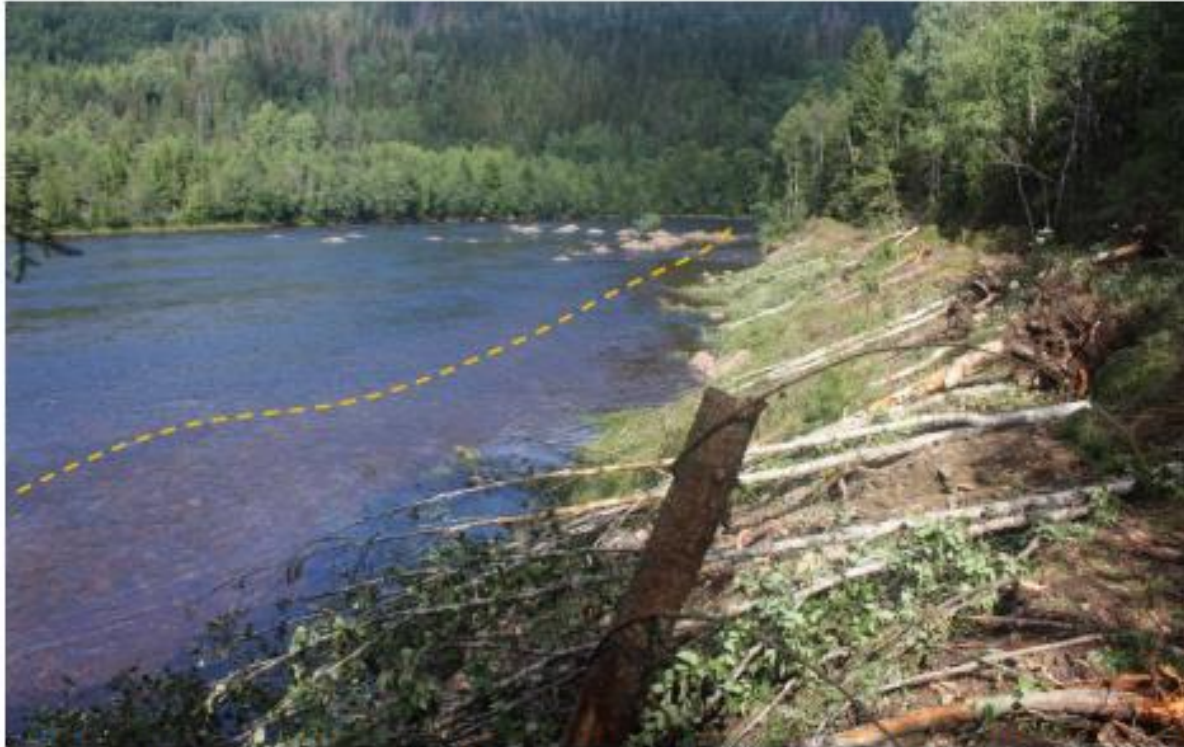
Figur 6. En bred og lang rensvall har her återförts till älven, vilket ökat älvbredden med ca 10 meter. Den tidigare strandkanten är markerad med gul streckad linje. Tillfört material skapade mer naturliga strömbilder samt mängder med skydd för småfisk. De små "öarna" med sten som syns i bakgrunden kommer från vallen och spreds senare ut över hela älvbredden. De liggande träden kommer bidra till viktiga övergångsmiljöer mellan vatten och land.
